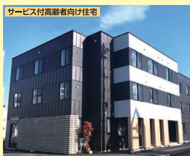
サービス付高齢者向け住宅
